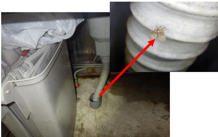
発生事例3: 排水管の中に幼虫がいて、ドレンホースと排水管の隙間から成虫になって上ってきていました。これはこの隙間をコーキングすることで対応できますが、排水管の中からドレンホースを伝って這い上がって来る成虫は、防止することはできません。定期的なドレンホースの清掃が基本ですが、できない場合や清掃が行き届かない場所が心配される場合には、排水管の中に注入できる泡洗浄タイプの殺虫剤を使用します。また、物理的方法の資材として排水管の径に合わせたグリーン・ドレインの設置をお勧めします。裏面下部にその紹介を掲載します。(M.K.)
