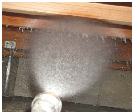
床下での薬剤散布処理
