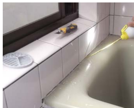
浴室で隙間を確認し薬剤を注入
