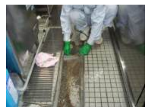
埋設配管洗浄作業
