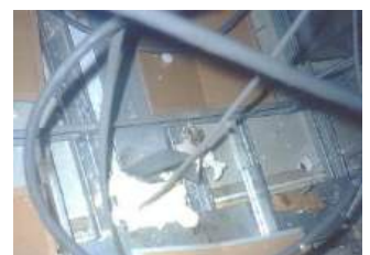
防鼠工事(パテ施工)
